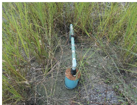
รูปที่ 2-10: บ่อบาดาลเพื่อนำน้ำมาใช้ในการกิจกรรม ของโครงการในช่วงแรกการทำเหมือง
