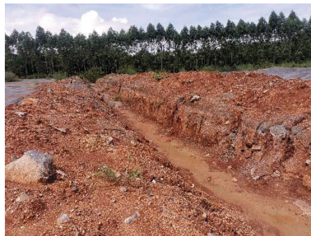
รูปที่ 2-2: คันทำนบดินและคูระบายน้ำ รอบกองเก็บเปลือกดิน
